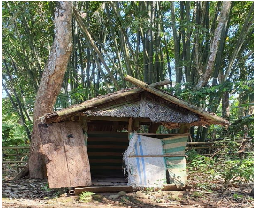
Gambar 4.11 Tampak Depan Jamban Cubluk Tanah
