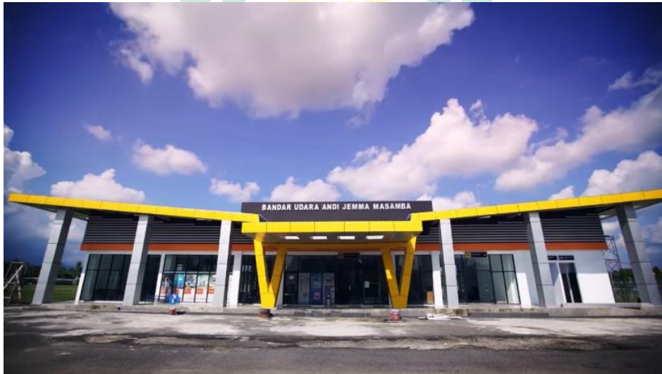
Gambar II.9 Tampak depan Terminal Penumpang Bandar Andi jemma Sumber : http://hubud.dephub.go.id (diakses 30 september 2019)
