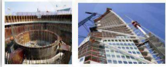
Gambar II.18. Proses Konstruksi (Sumber : www.archdaily.com , 2019)
