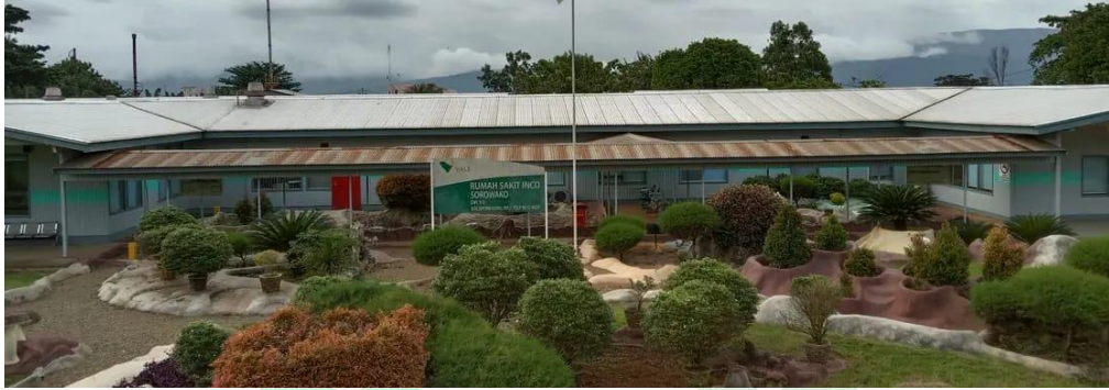
Gambar 4.1 Bangunan RS Awal Bros Kecamatan Nuha
