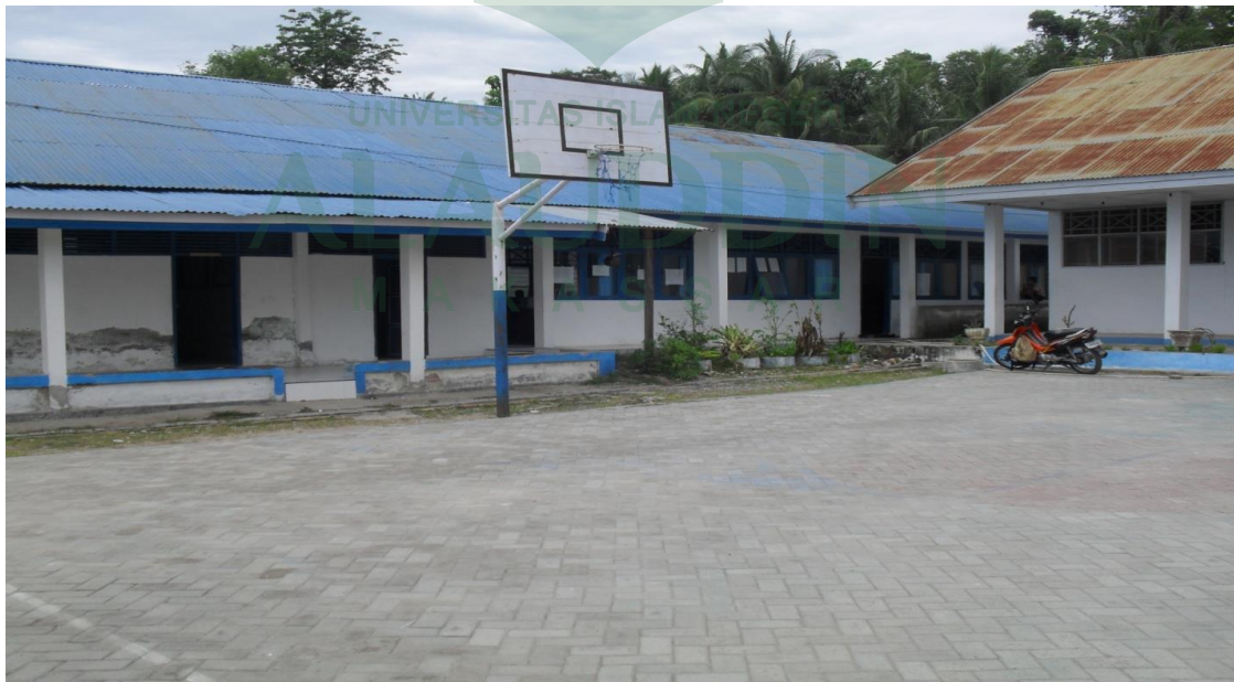
GEDUNG SMPN 1 TINAMBUNG KABUPATEN POLMAN
