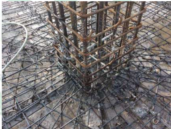
Gambar III.10 Pondasi Rakit
