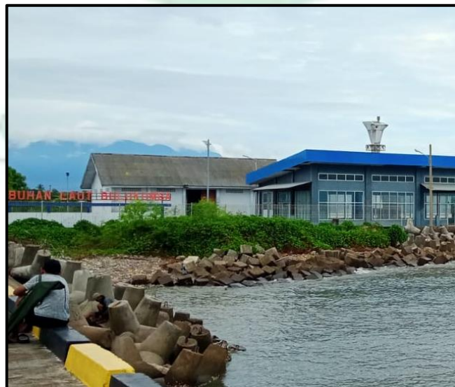
Gambar 39. Kondisi Pemecah Gelombang/Breakwater di Kecamatan Ujung Bulu Sumber : Hasil Survey Lapangan, 2022
