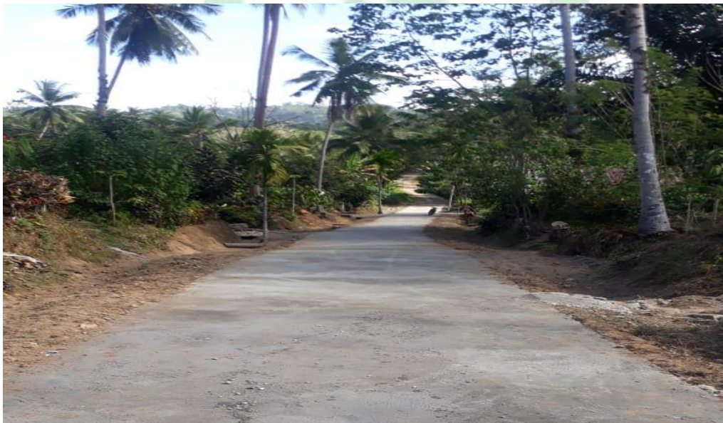
Kondisi jalan pendidikan setelah pelaksanaan kegiatan pembangunan.
