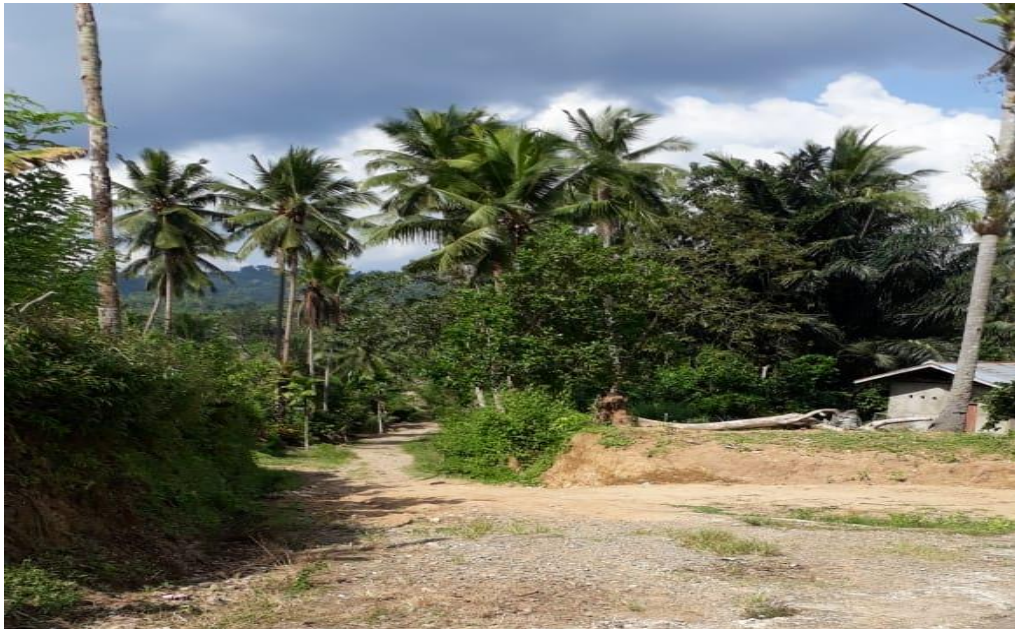
Kondisi jalan pendidikan sebelum pelaksanaan kegiatan pembangunan.
