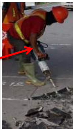
Potensi bahaya getaran dari mesin jack hammer
