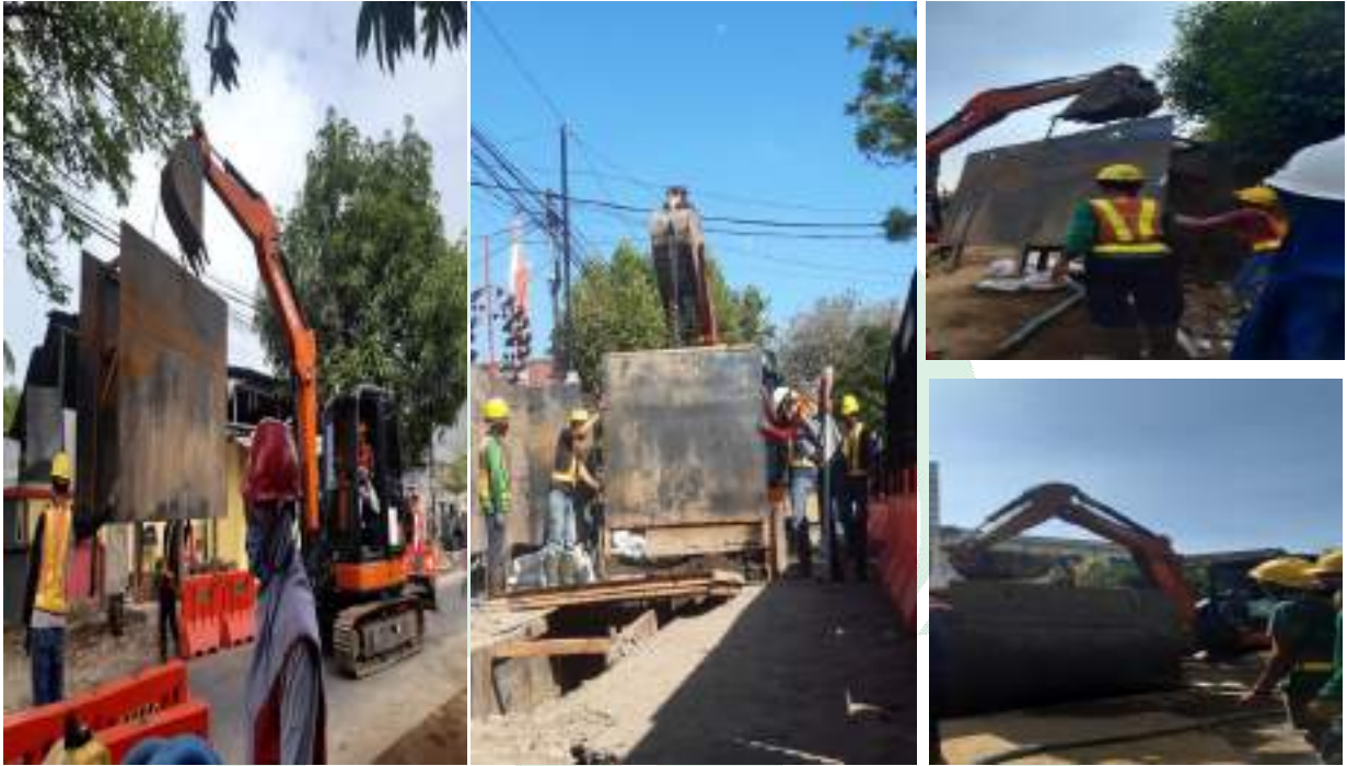
Gambar pemasangan shoring
