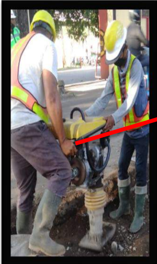
Potensi bahaya getaran dari mesin jack hammer
