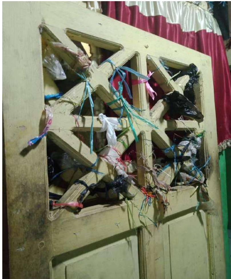
Foto 8. Ikat Simpul Plastik Di Dinding-Dinding Bangunan
