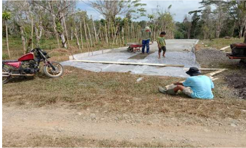
Gambar 6. Pembangunan Infrastruktur Fisik (Pengecoran)
