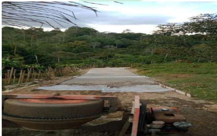
Gambar 5. Pembangunan Pengecoran Jalan
