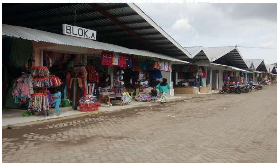
Gambar 2. Bangunan Pasar Rakyat Sungguminasa (Sungguminasa, 17 Mei 2022)
