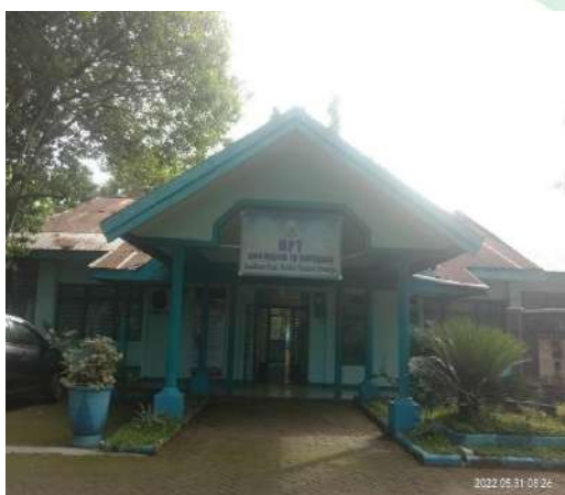
Dokumentasi Jalan Masuk
