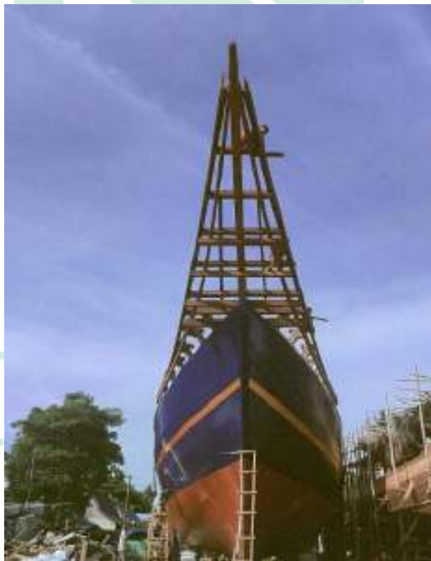
Foto 18: Pengerjaan kapal pinisi yang pengerjaannya hampir rampung
