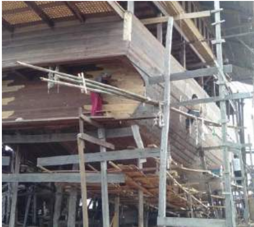
Foto 15: bagian belakang kapal pinisi
