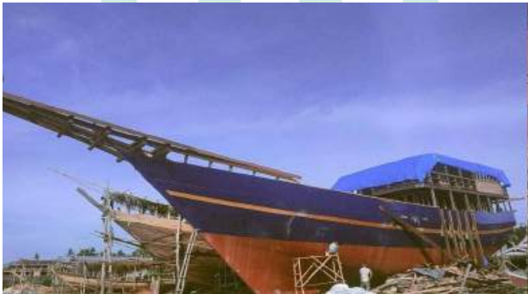
Foto 16: Pengerjaan kapal pinisi yang pengerjaannya hampir rampung
