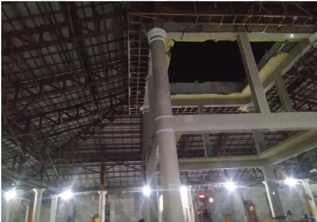
4. Proses Pembangunan Khubah Masjid Raya Campalagian
