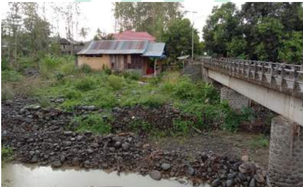
Rumah warga yang tidak sesuai dengan garis sempadan sungai pada Sungai Cabbue
