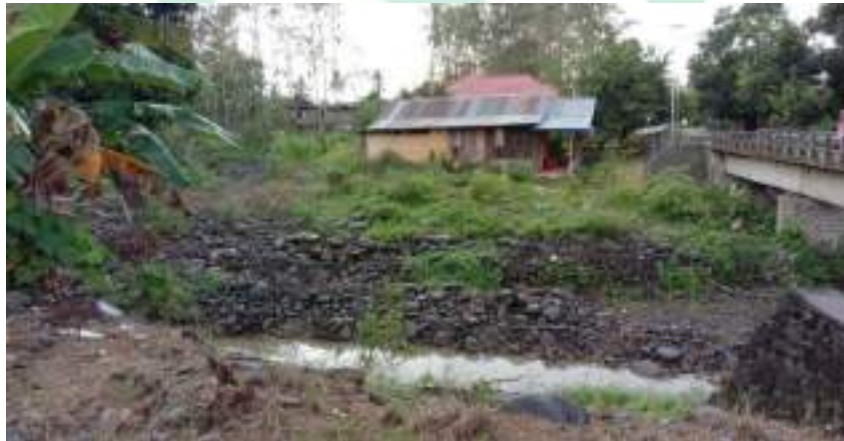
Gambar 4. Rumah warga tidak sesuai garis sempadan sungai
