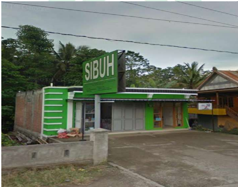
Gambar 4.1 Tampak Bangunan Awal CV. Sibuh Kabupaten Soppeng
