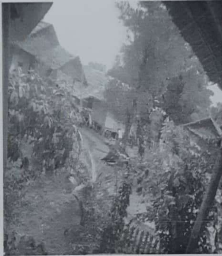
Dari kejauhan Nampak anggota An-Nadzir sedang membangun pondokan dengan sistem gotong royong
