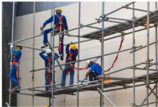
Gambar 16 Penggunaan Perancah oleh Pekerja Konstruksi Sumber : (Safety Sign 2018b)
