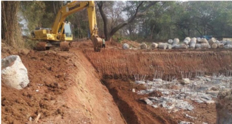
Gambar 30 Pekerjaan Tanah Sumber : (PT Prima Maju Jaya 2018)
