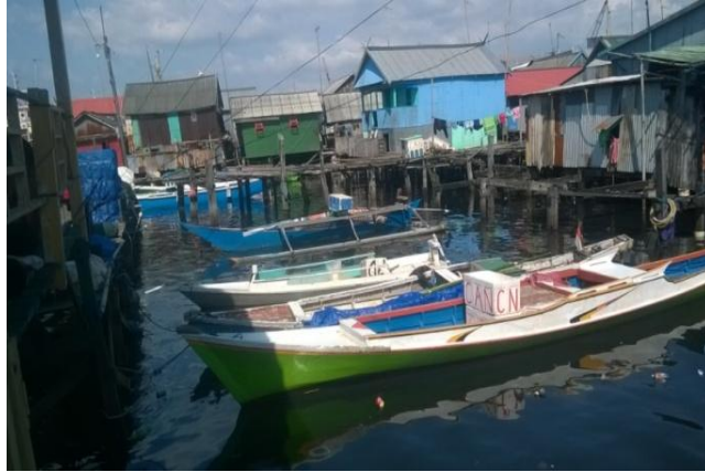
Gambar II.3: Kondisi pemukiman warga di pinggir air laut
