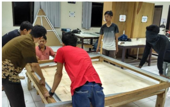
Gambar IV.20: Hasil model pemasangan saluran air pada rangka wadah penampungan
