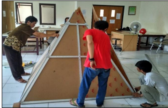
Gambar IV.9: Proses pemasangan rangka piramida dengan menggunakan fiber secara keseluruhan
