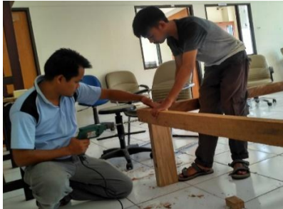
Gambar IV.11: Proses pemasangan balok dan pengoboran
