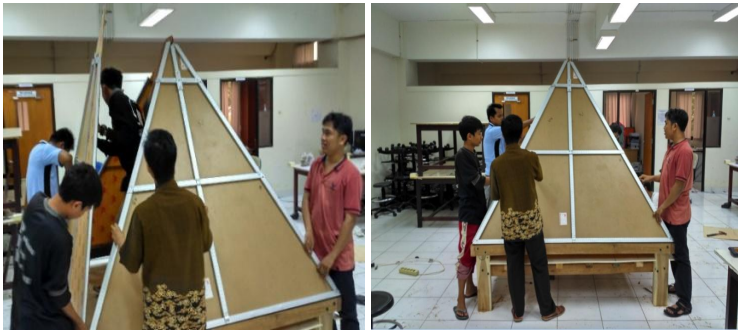
Gambar IV.17: Pemasangan empat dinding piramida di atas wadah penampungan air baku
