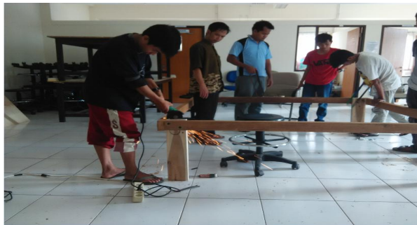
Gambar IV.12: Proses pengeboran dan pemasangan baut pada setiap sisi sambungan balok
