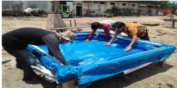
Gambar IV.26: Proses pemasangan wadah penampungan
