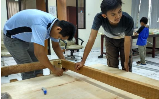
Gambar IV.15: Proses pengaturan tripleks di atas penyangga balok
