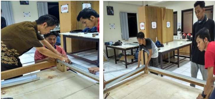
Gambar IV.19: Proses pemasangan saluran air pada rangka wadah penampungan
