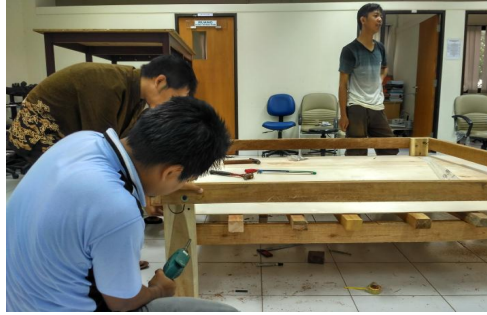
Gambar IV.16: Proses pemasangan tripleks sebagai tempat (lapisan) wadah penampungan air baku (air laut)
