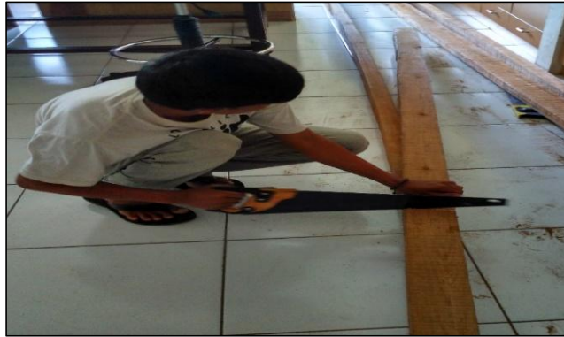
Gambar IV.10: Proses pemotongan kayu yang akan dijadikan rangka
