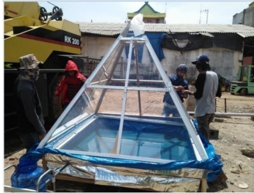
Gambar V.2: Pemasangan alat pengolah air laut di lokasi pengabdian
