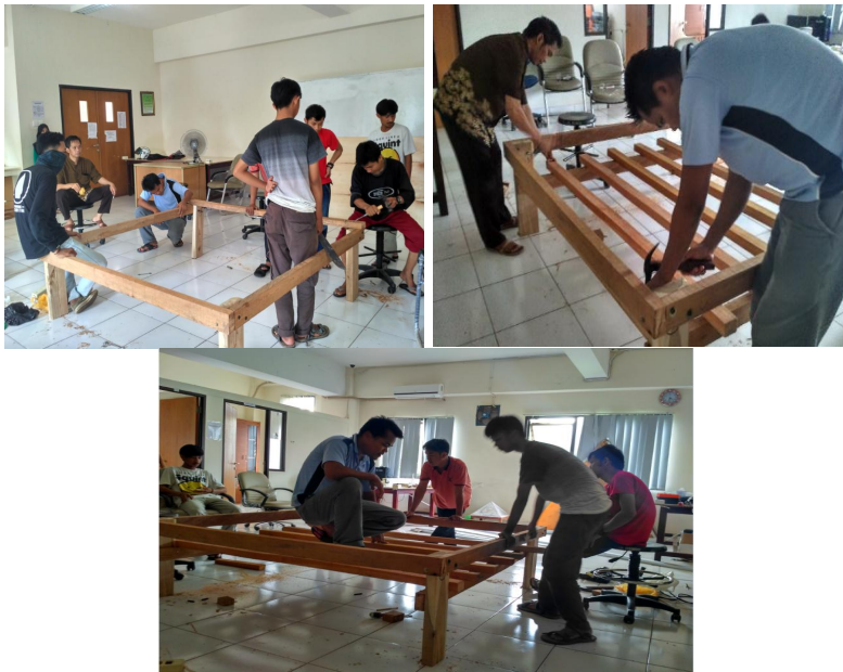
Gambar IV.14: Proses pemasangan balok sebagai penyangga wadah penampungan
