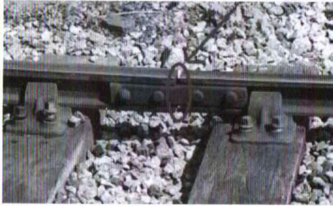
Gambar 6.3 Sambungan Rel Kereta Api
