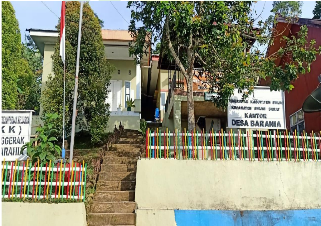
Gambar 1: Kantor Desa Barania Kecamatan Sinjai Barat Kab. Sinjai
