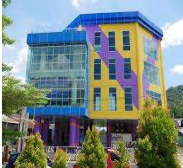
Gambar 1. Gedung Dinas Perpustakaan dan Kearsipan Kabupaten Enrekang
