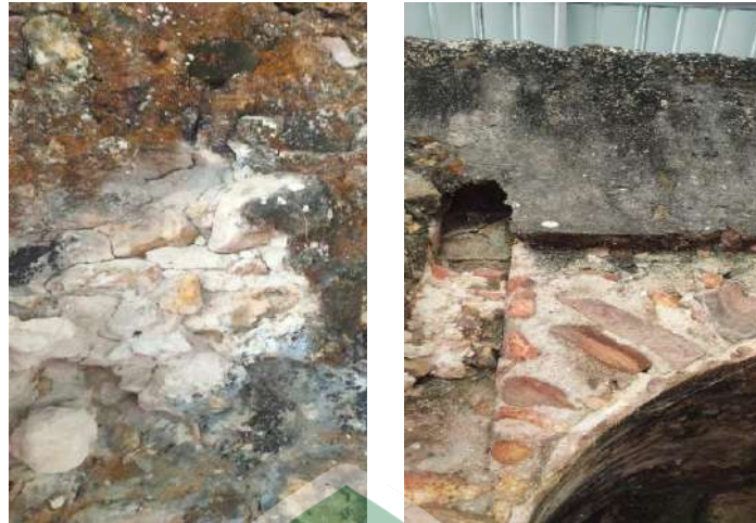
Gambar 14. Sisa bangunan Masjid yang terbuat dari telur bisa dibandingkan, jika berwarna kuning maka itu bangunan asli yang perekatnya terbuat dari putih telur dan yang berwarna hitam sudah memiliki campuran semen karena Mihrabnya sudah hampir runtuh.
