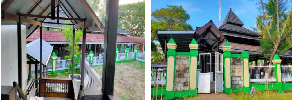
Gambar 8. Pintu arah kanan dan kiri masjid Sumber : Dokumentasi Pribadi (tanggal 10 Oktober 2022)
