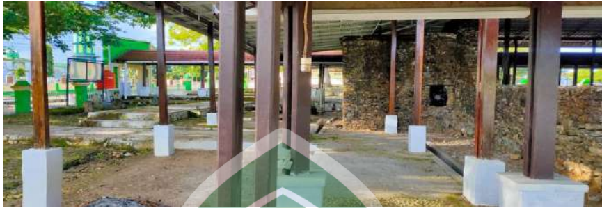
Gambar 4 : Tiang untuk menopang atap Masjid Tua Tosora Sumber : Dokumentasi Pribadi (tanggal 10 Oktober 2022)
