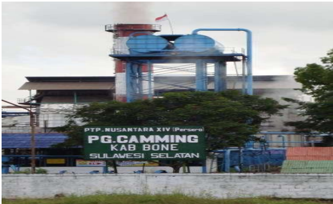
GAMBAR 1: Bangunan Pabrik Gula Camming dari sisi depan
