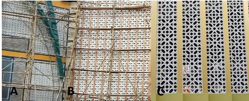
Elemen roster ini menutupi hampir seluruh permukaan dinding luar kecuali pada bagian akses pintu masuk (entrance) pada keempat sisi bangunan dan pada tangga utama yang terletak di bagian belakang masjid.
