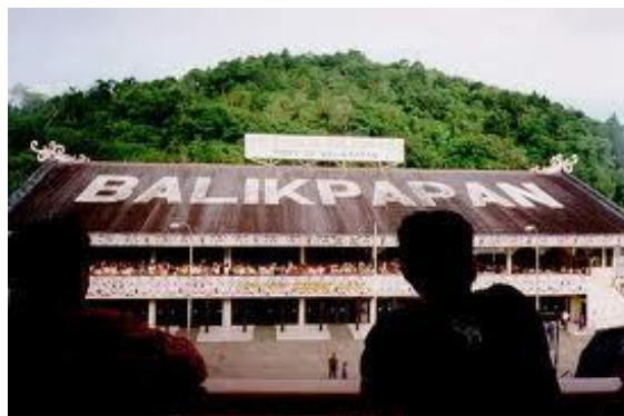
Gbr II.7 Bangunan Terminal Pelabuhan Balikpapan (Sumber : http://Balikpapan.co.id )
