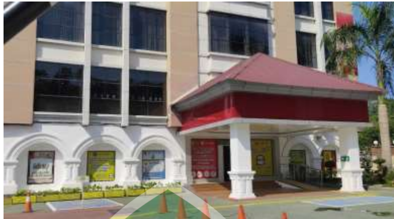
Gambar 6. Foto Gedung Utama Pengadilan Negeri Makassar kelas 1A
