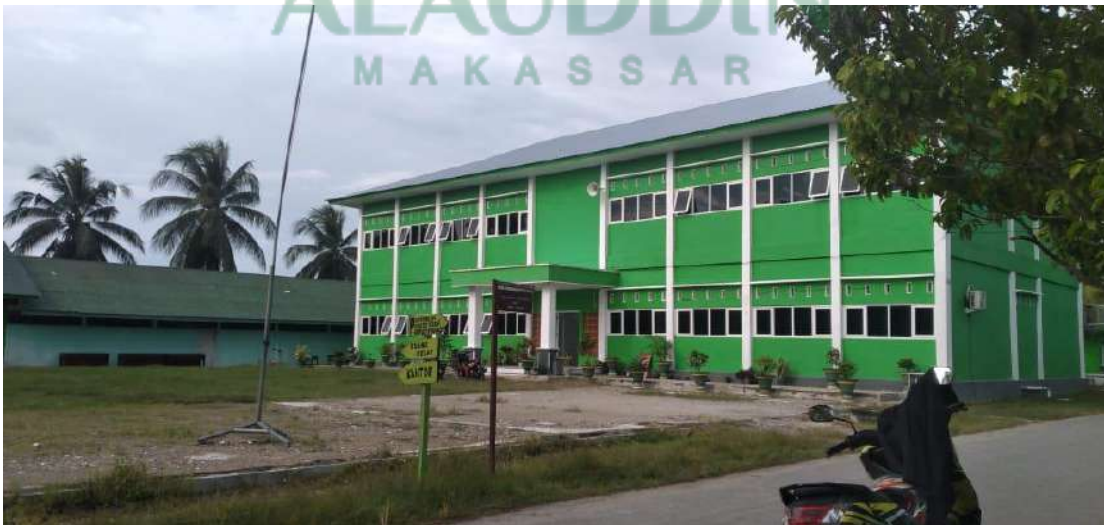
Gedung Para Tenaga Pelajar Pondok Pesantren Modern Al-Ikhlas
