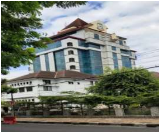
Keterangan Gambar 1: Kantor Balai Kota Untuk Dinas Pemberdayaan Perempuan, Perlindungan Anak dan Pemberdayaan Masyarakat Kota Makassar
