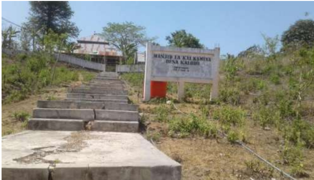
Gambar 5: Tangga Akses Jalan Menuju Masjid Kamina
