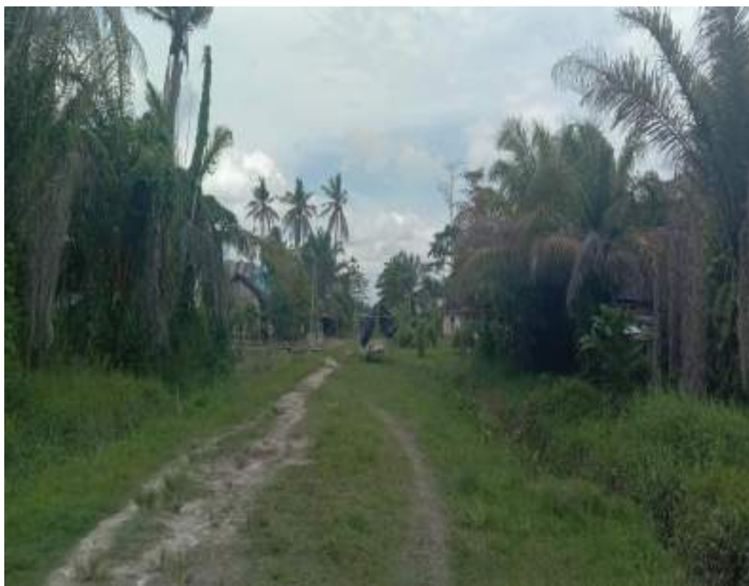
Kondisi Jalan pada Dusun Cempaka II Desa Beringin Jaya
