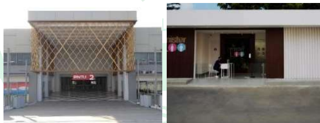
Gambar II. 25 Entance dan Toilet (sumber: Purwantor Joko Slameto. 2020)
