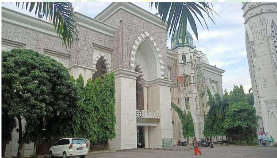
Gambar 4: Tampak Samping Masjid dari Arah Selatan
