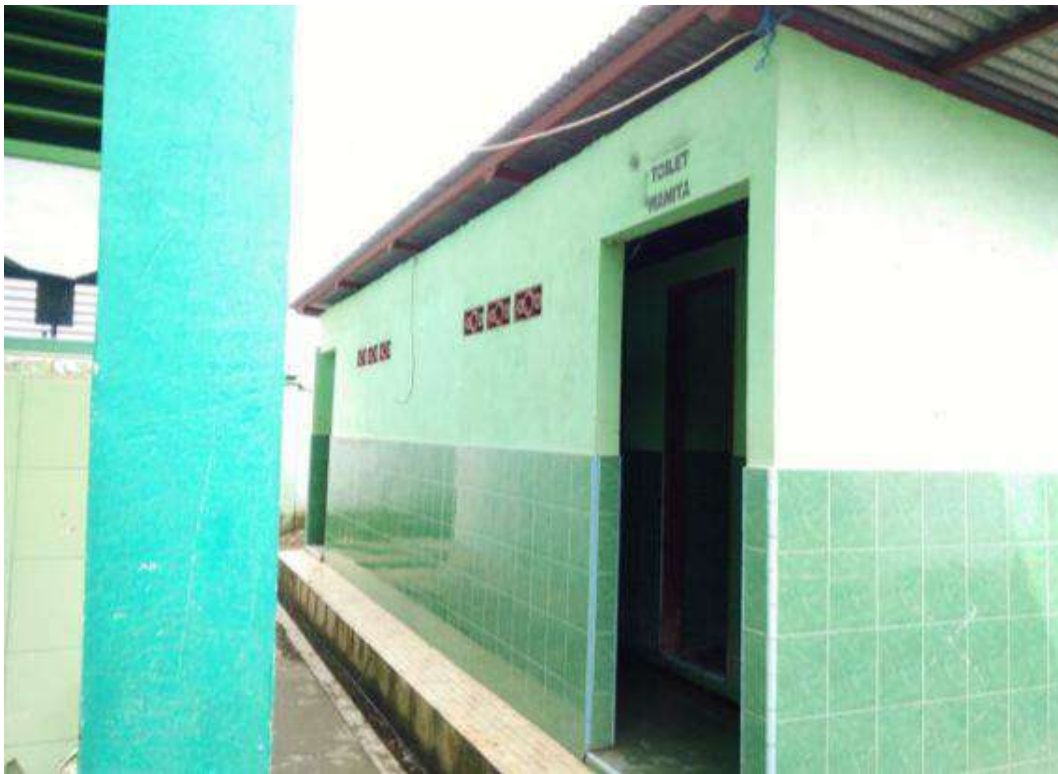
Toilet di SMP Negeri 1 Cempa
