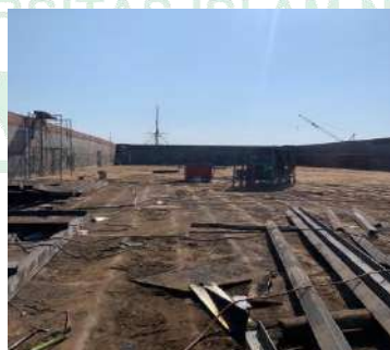
Kondisi kabel las saat pengelasan
