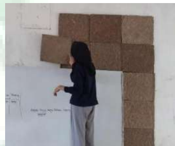
Proses pemasangan peredam kebisingan
