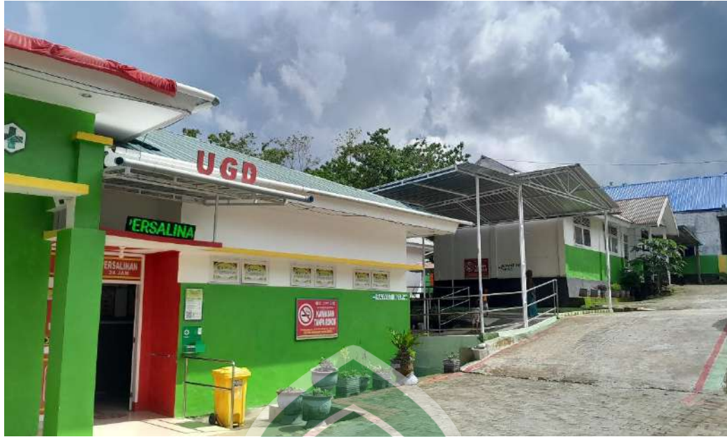
Dokumentasi atau potret gedung rawat inap bersalin, pasien umu dan pasien JKN Puskesmas Bontocani
