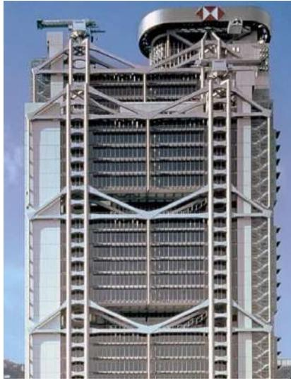
Gambar II.30 Pemakaian kolom baja sebagai struktur utama bangunan Shanghai and Hongkong Bank karya Norman foster
