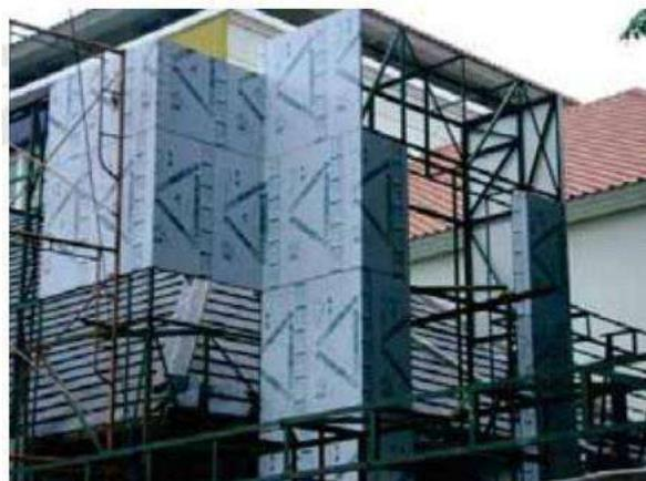
Gambar II.32 Pemakaian modul rangka struktur terfabrikasi pada bangunan
