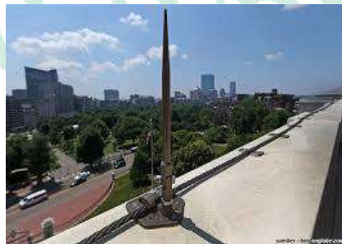
Gambar III. 25 Sistem penangkal petir
