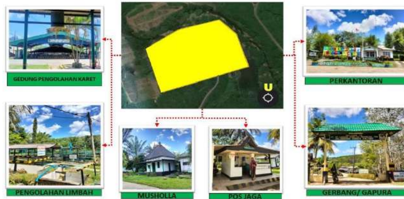
Gambar III. 5 Kondisi Existing Pabrik Pengolahan Karet (Sumber: Olah Data, 2023)
