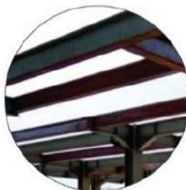
KONSTRUKSI BALOK BAJA
