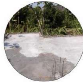
KONSTRUKSI PLAT BETON
