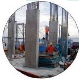
KONSTRUKSI KOLOM BETON
