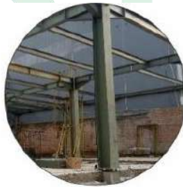
KONSTRUKSI KOLOM BAJA
