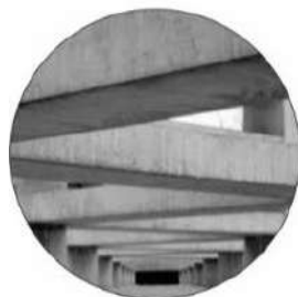
KONSTRUKSI BALOK BETON
