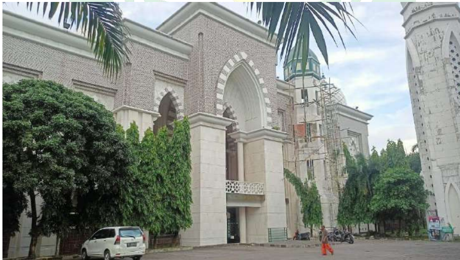
Gambar 4: Tampak Samping Masjid dari Arah Selatan
