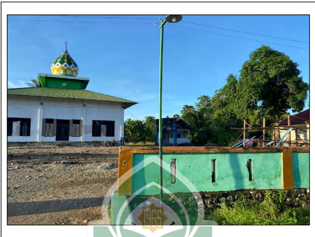
Foto Masjid Desa Baturube, Kec. Bungku Utara, Kab. Murowali Utara
