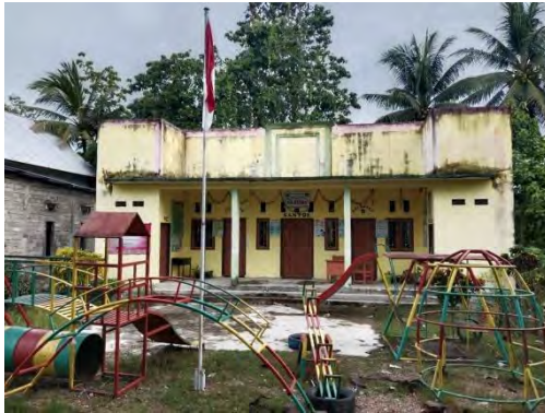
Gambar 5.3 Bangunan Tk Ar-Ridha
