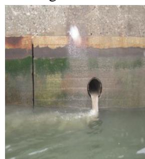
Sampah dihaluskan kemudian dimasukkan ke dalam sistem pembuangan air limbah. Metode ini dapat efektif asalkan sistem pembuangan air limbah berjalan baik.
