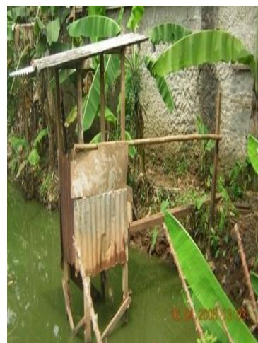
Jamban tipe empang adalah jamban yang kotorannya dibuang atau dialirkan ke lubang atau empang. Hal semacam ini biasa juga dilakukan di atas sungai atau
