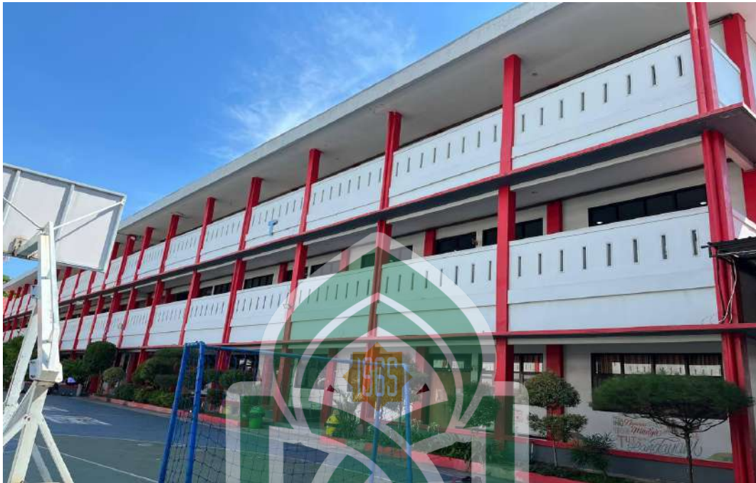
Gambar 1: Gedung utama SD Telkom Makassar
