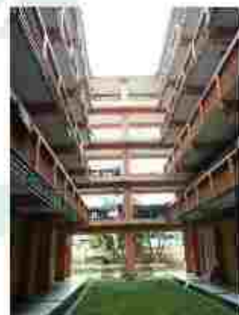
Gambar II. 15 Interior Rumah Susun Pharmindo (Sumber : Atieka, 2017)
