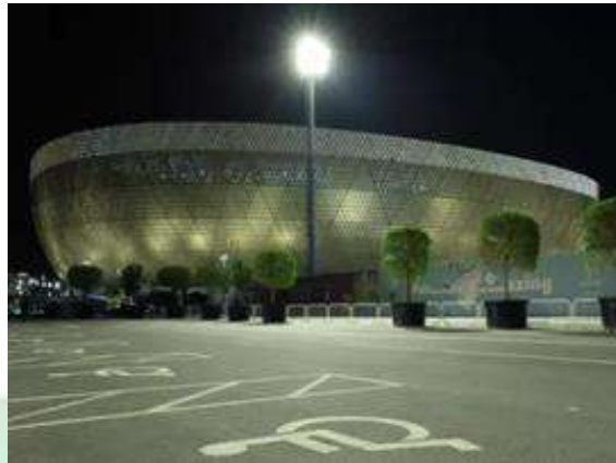
Gambar 4. 4 Tempat Parkir Khusus Penyandang Disabilitas
