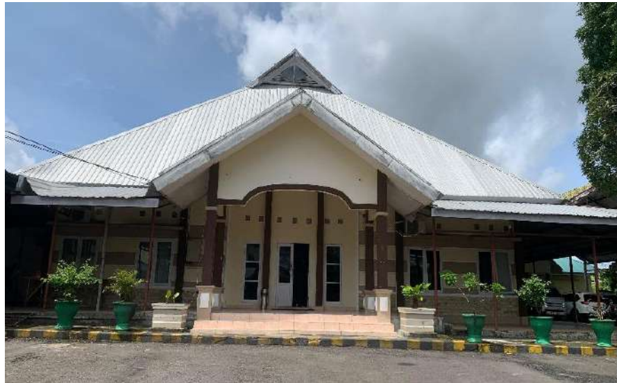
Gambar 4. 21 Gedung Kantor UPT Asrama Haji Embarkasi Makassar
