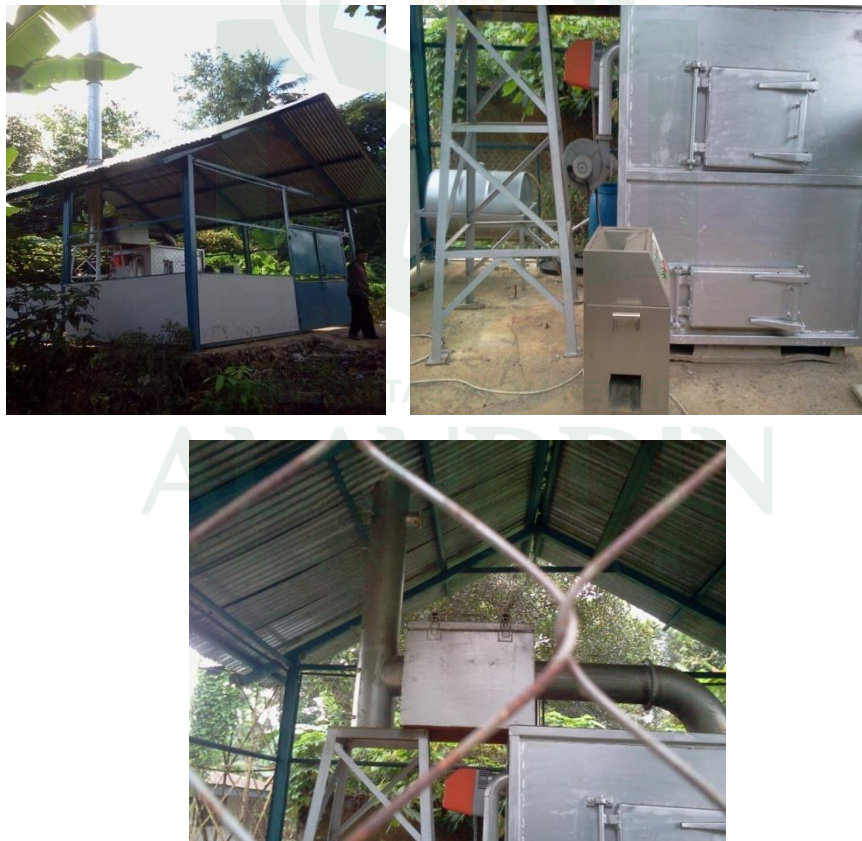
Gambar 5 Insinerator yang belum digunakan
